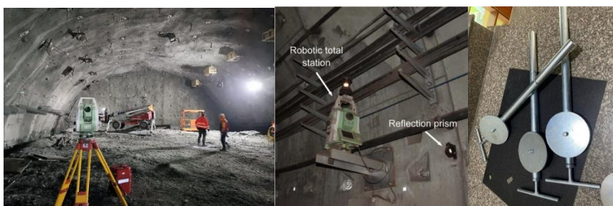
Hình 7; 8. Một số dạng mốc dùng trong thi công đường hầm (Nguồn: Internet)
