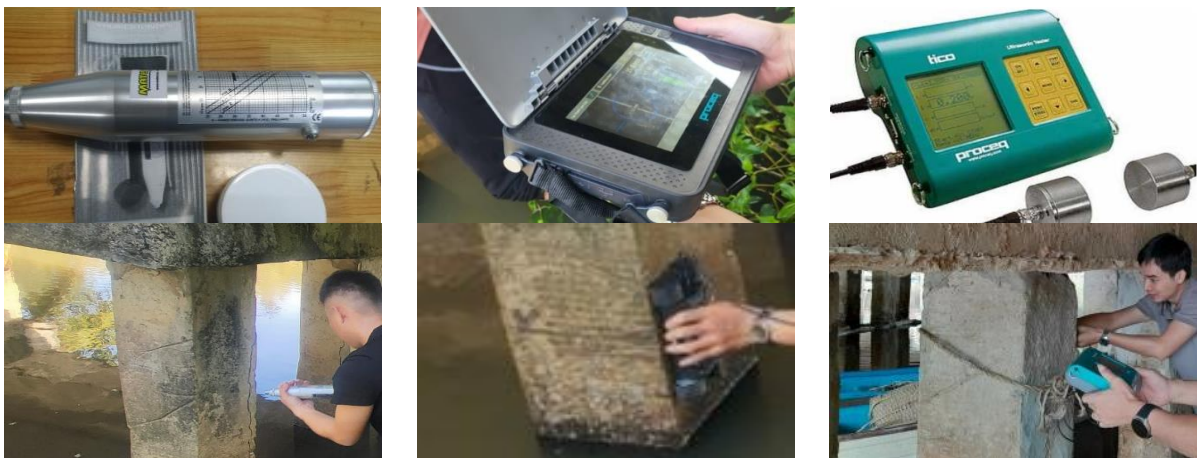
a) Khảo sát bằng súng bột nảy b) Khảo sát bằng máy dò thép c) Khảo sát bằng máy siêu âm Hình 1. Một số hình ảnh về khảo sát công trình BTCT được lấy nghiên cứu [16]
