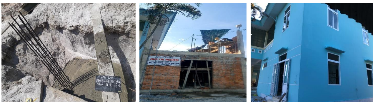
Hình 5. Quá trình thi công công trình
