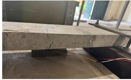
b. Tấm bê tông sau khi va đập bị nứt
