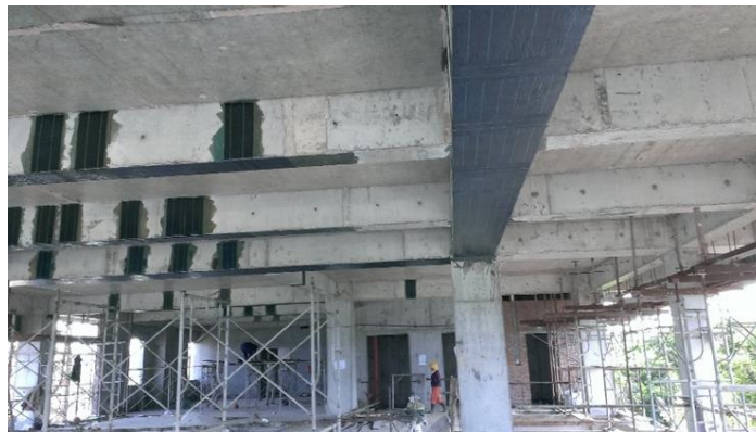
Hình 2. Sử dụng CFRP gia cường kết cấu công trình [11]
