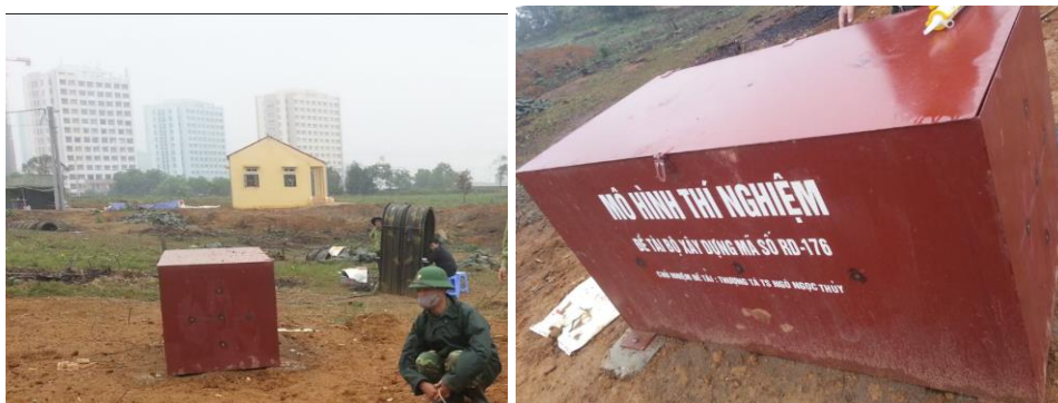
Hình 6. Hình ảnh thí nghiệm nổ với lượng nổ đặt trên mặt đất cách mặt tường trước công trình 4m
