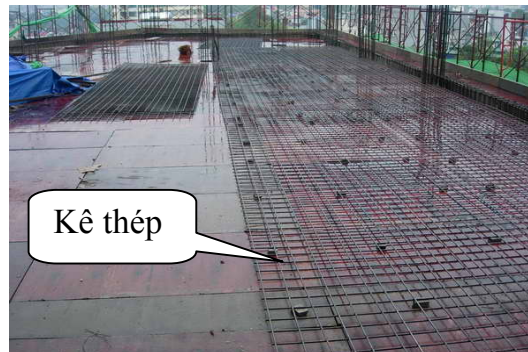
Hình 11. Lưới thép cho sàn U-Boot Beton
