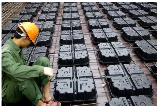
Hình 12. Lắp đặt hộp nhựa cho sàn U-Boot Beton
