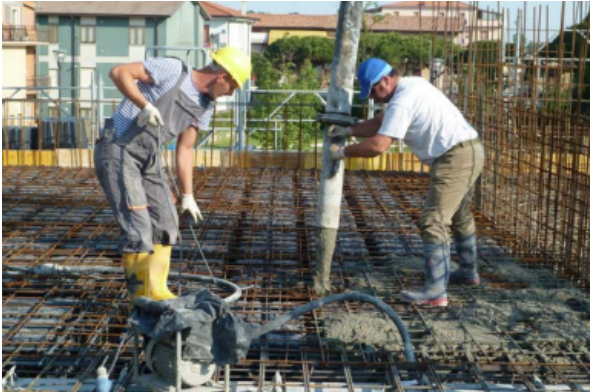
Hình 16. Đổ bê tông phần còn lại của sàn
