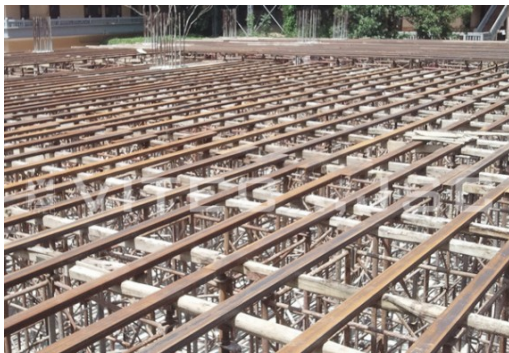
Hình 10. Lắp dựng hệ cột chống, đà giáo và ván khuôn cho sàn U-Boot Beton
