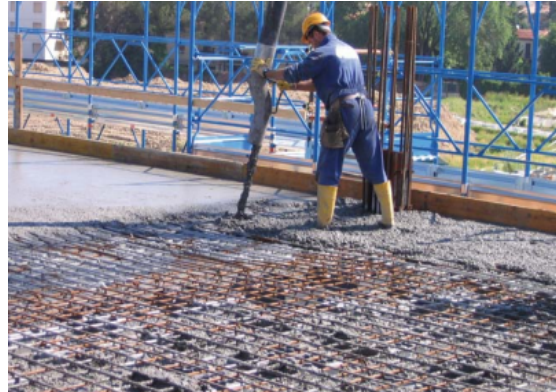
Hình 16. Đổ bê tông phần còn lại của sàn
