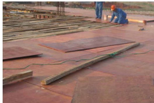
Hình 10. Lắp dựng hệ cột chống, đà giáo và ván khuôn cho sàn U-Boot Beton
