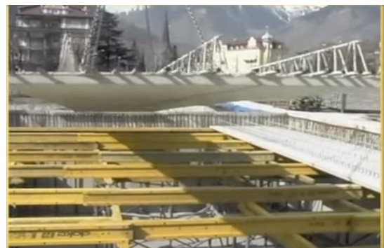
Hình 15. Bốc dỡ tấm sàn U-Boot Beton
