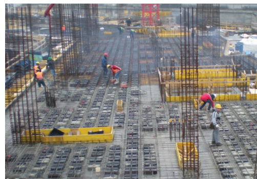
Hình 12. Lắp đặt hộp nhựa cho sàn U-Boot Beton
