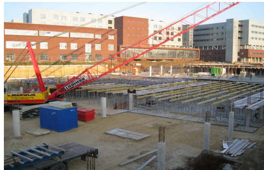
Hình 14. Hệ đỡ sàn U-Boot Beton
