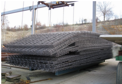
Hình 11. Lưới thép cho sàn U-Boot Beton
