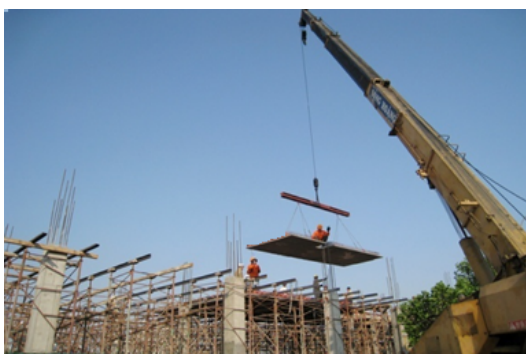
Hình 15. Bốc dỡ tấm sàn U-Boot Beton
