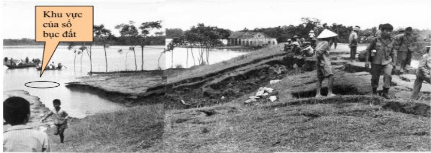
Hình 2. Hình ảnh phá hủy thấm nền đê Văn Cốc - Hà Tây năm 1986
