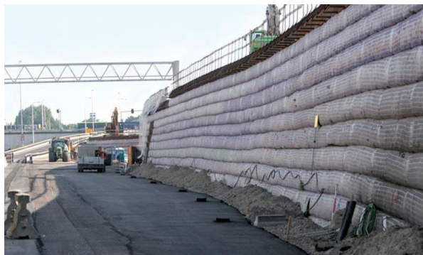
Hình 6. Bề mặt tường bằng gạch/đá và cuốn bằng vải ĐKT
