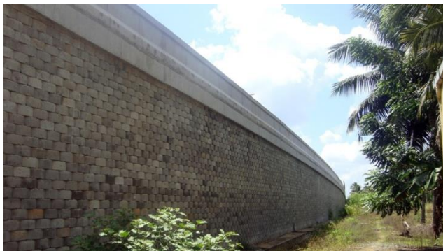
Hình 6. Bề mặt tường bằng gạch/đá và cuốn bằng vải ĐKT
